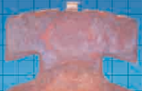
熱負荷後の錆
